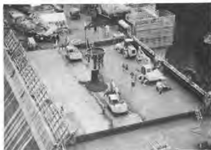
写真-2 左右岸方向打設状況
