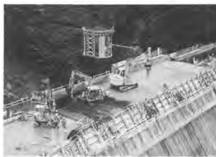
写真-3 上下流方向打設状況
