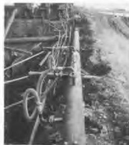
写真 3-4 パイプシャワー設置状況
