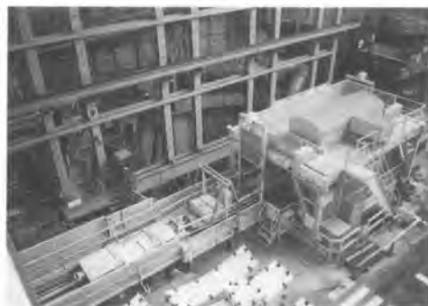
写真-2. セグメント台車と牽引台車
