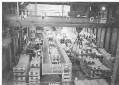
写真-1. 地上走行路設備
