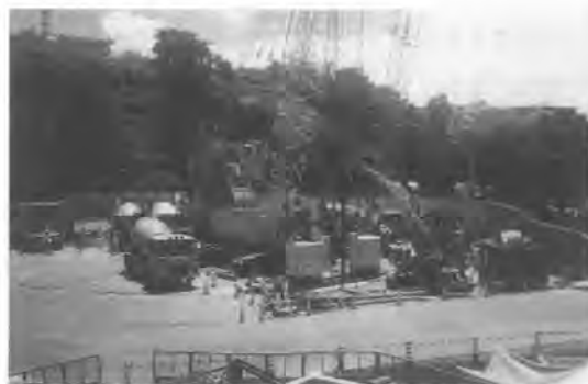
写真-5 施工風景
