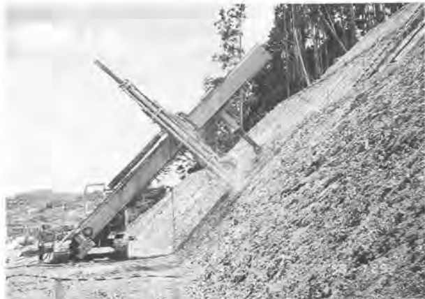
写真-3 ABS稼働状況
