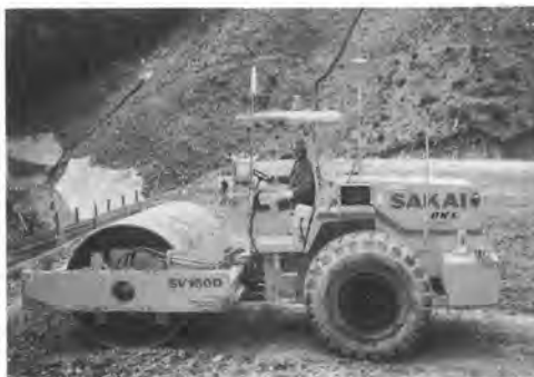
写真-2 システムを搭載した振動ローラー
