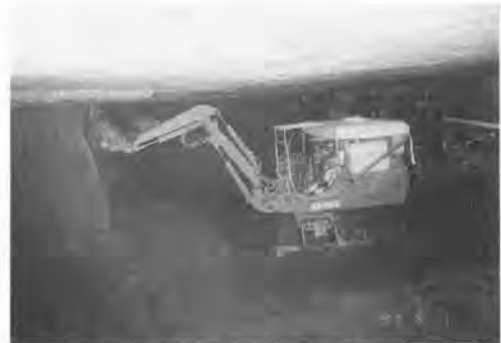
写真一 2 ミニショベルによる掘削状況②
