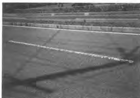
写真-1 施工前状況
