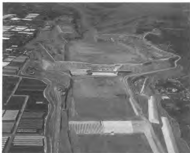
写真-9 工事完了全景
