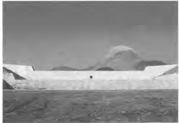
写真-1 完成したダム越流部
