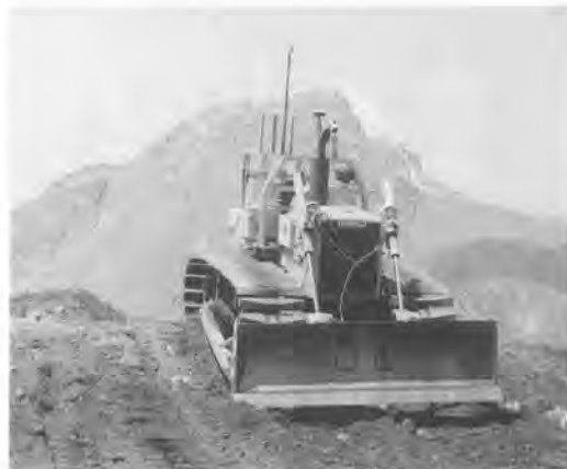
写真-4 法面掘削状況
