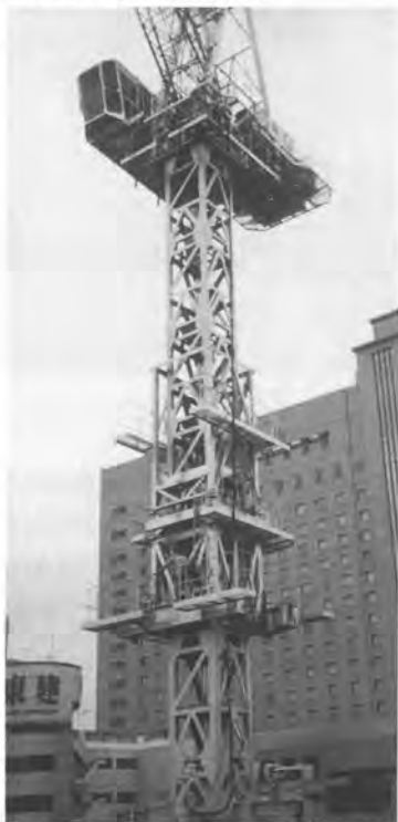
写真-3 昇降装置上昇状況
