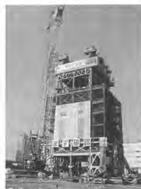
3号ボイラ棟の施工
