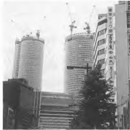
写真-2 工事外観
