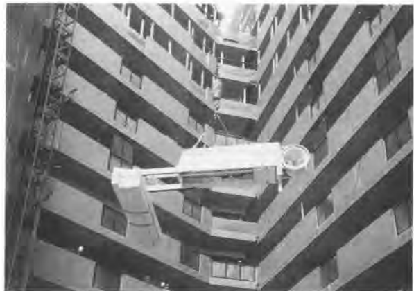
写真-1 搬送状況
