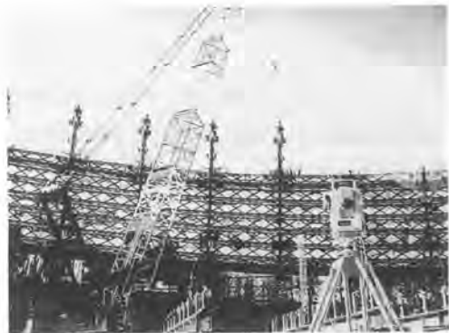
写真-1 鉄骨建方、計測状況
