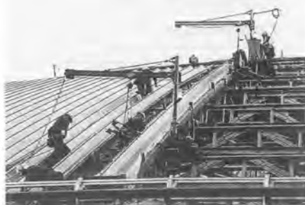
写真-2 敷設状況
