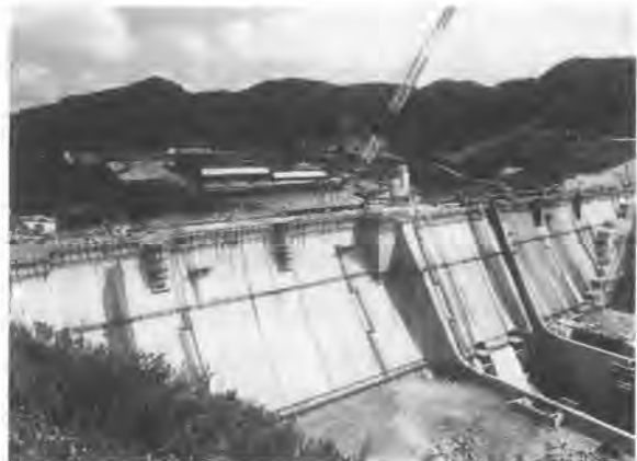
写真-2 堤体下流面配管
