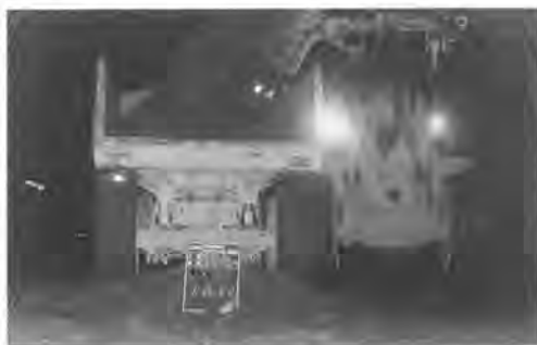
写真2 ずり搬出状況
