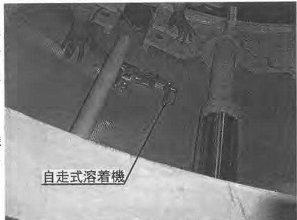
写真-5 円周方向の溶着状況
