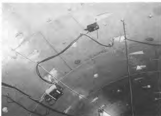
写真-2 固定局設置状況
