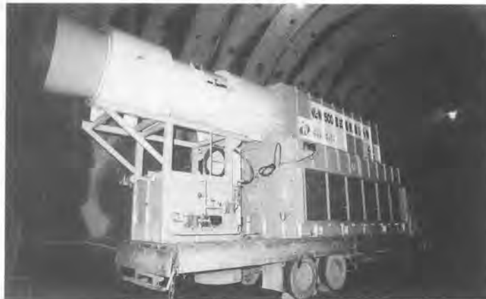
写真-2 電気集塵機坑内設置状況
