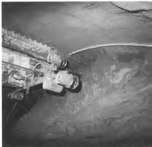
写真2 PASS施工状況
