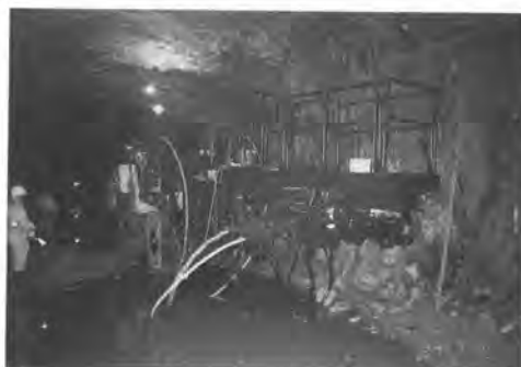
写真-3 ジャンボ通常作業状況
