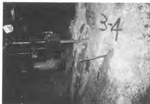
写真-2 ケーブルボルト切断・設置状況
