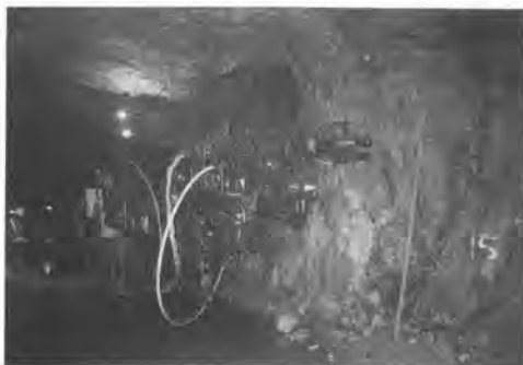
写真-1 ケーブルボルト打設状況
