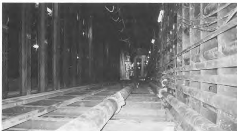
写真一2 坑内状況
