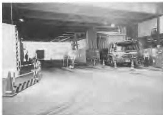
写真-1 発進立坑景観
