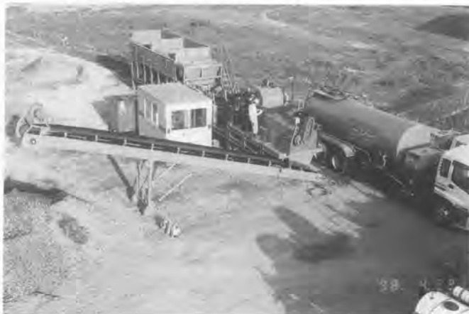
写真-1 本施工状況
