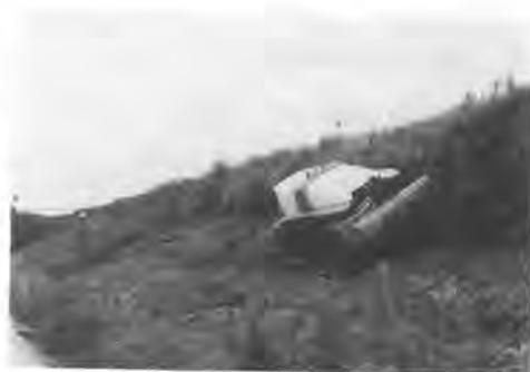
写真-2 作業状況
