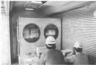
写真-4 遠隔操作状況
