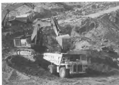
写真-3 施工状況2
