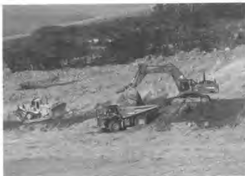
写真-2 施工状況1
