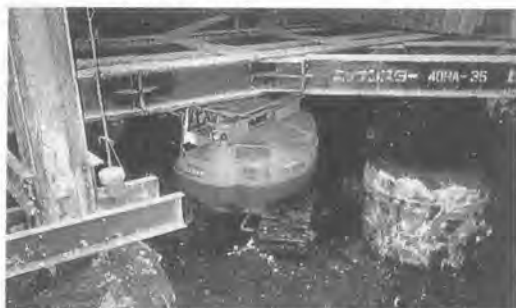
写真2. 地下貯水場工事現場とテスト車
