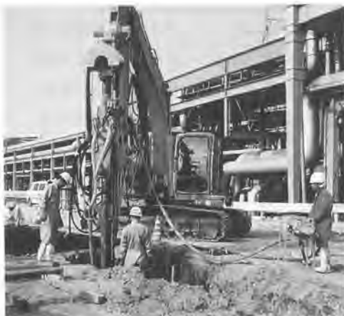
写真-1 打設状況 (雨水管部)
