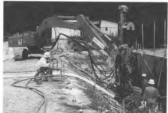
写真- 4 法面部の打設状況
