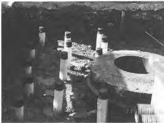
写真- 2 打設完了 (マンホール部)
