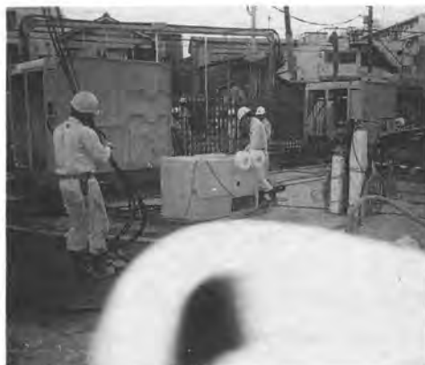
写真-2 建込み機械据付け
