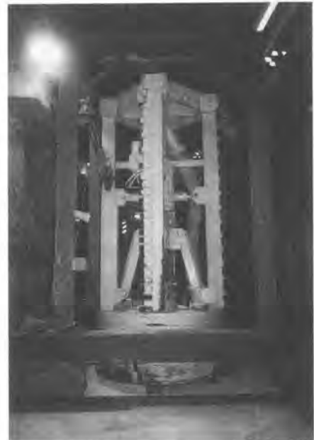
写真-2 投入台車稼動状況
