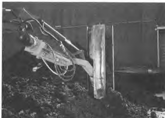
写真-2 リッパによる粗取作業
