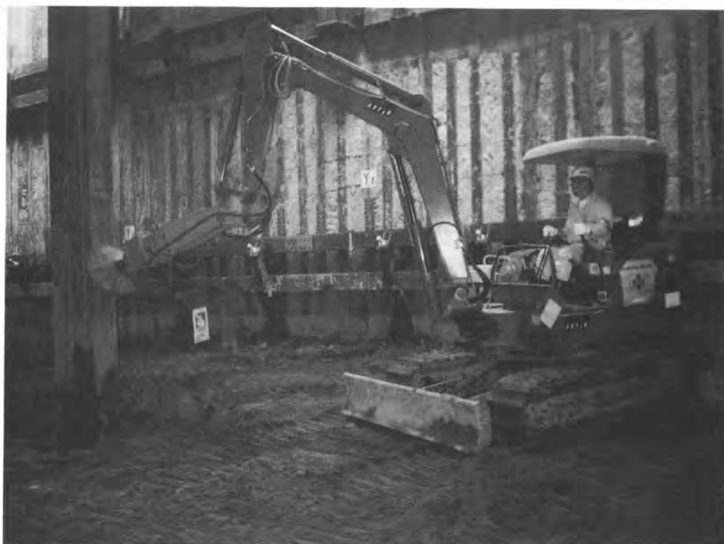
写真-7 構真柱ケレン機械全景
