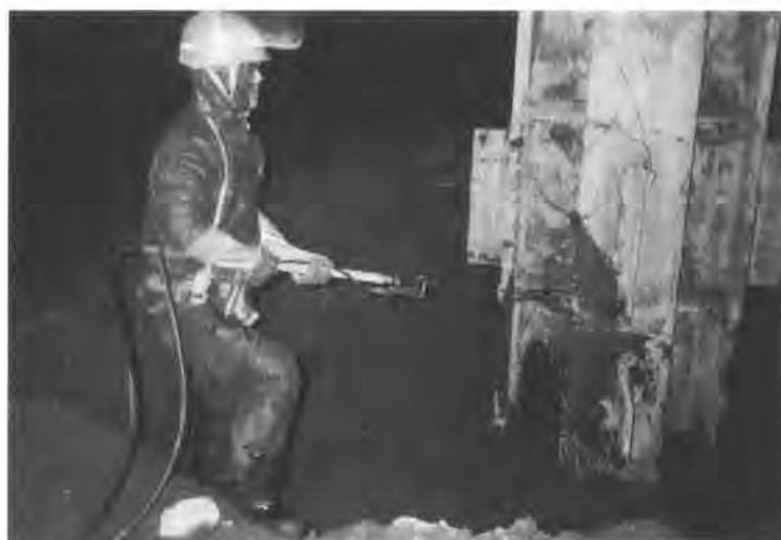
写真－1 高圧水によるケレン作業
