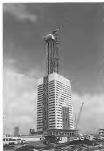
写真-3 施工状況
