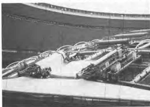
写真-2 施工全景
