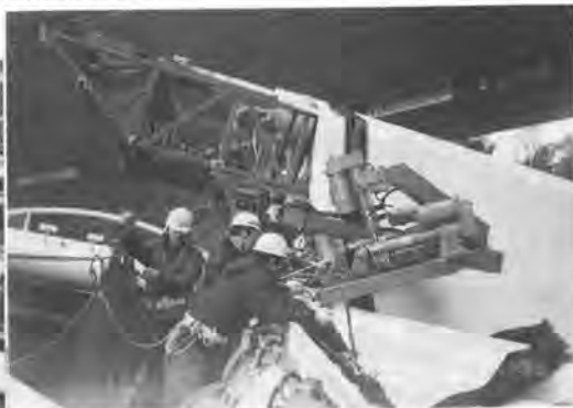
写真-3 施工状況
