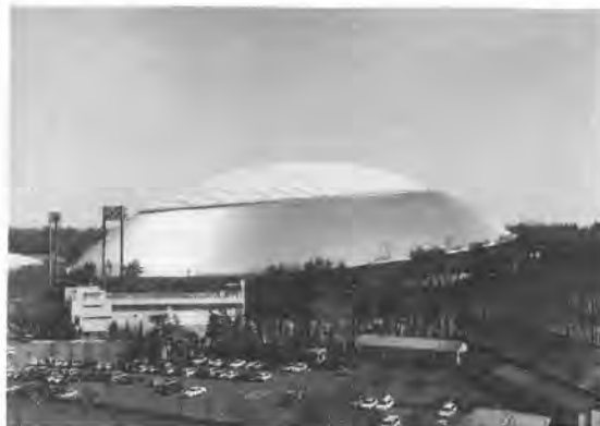
写真-1 屋根全景
