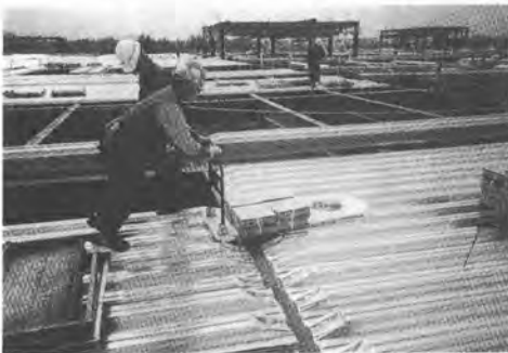
写真-14 資材搬送状況
