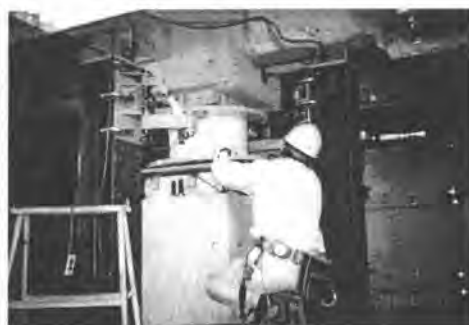
写真4 マニピュレータによる積層ゴム取付
