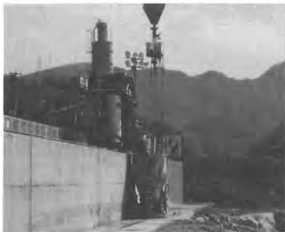
写真 - 1 コンクリート積込み状況 (サイドシュート式)
