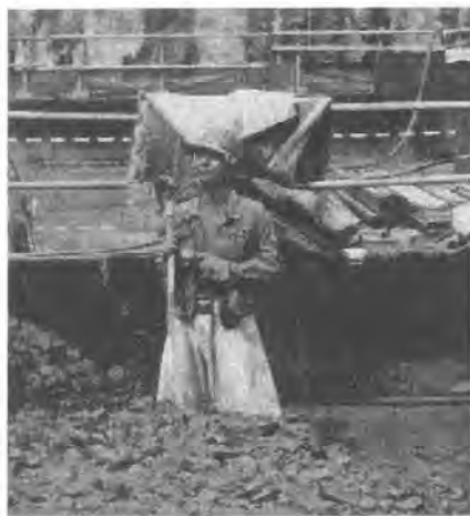
写真 - 2 打設位置指定状況
