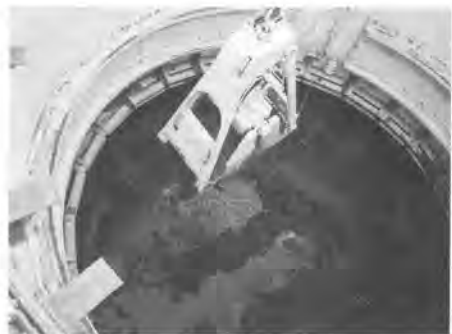
写真-2 ケーソン掘削
