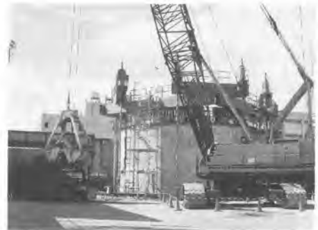
写真-1 現場状況
