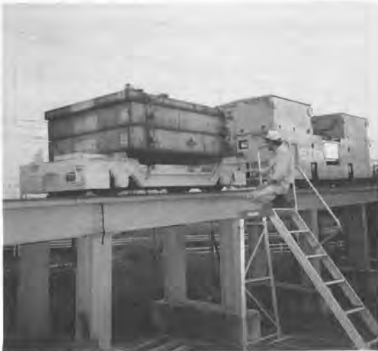
写真-2 セグメント台車積載状況
