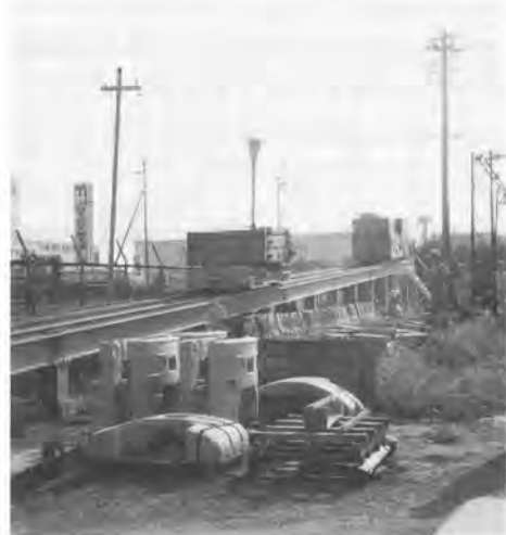
写真-3 制動試験状況
