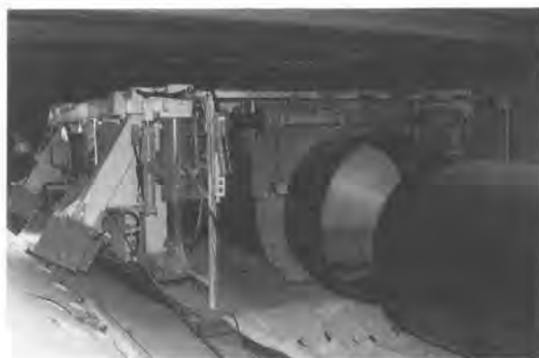
写真-1 導水管敷設状況
