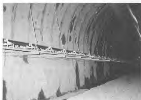
写真-5 掘削部吊り構造
