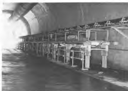
写真-5 ベルトストレージカセット
