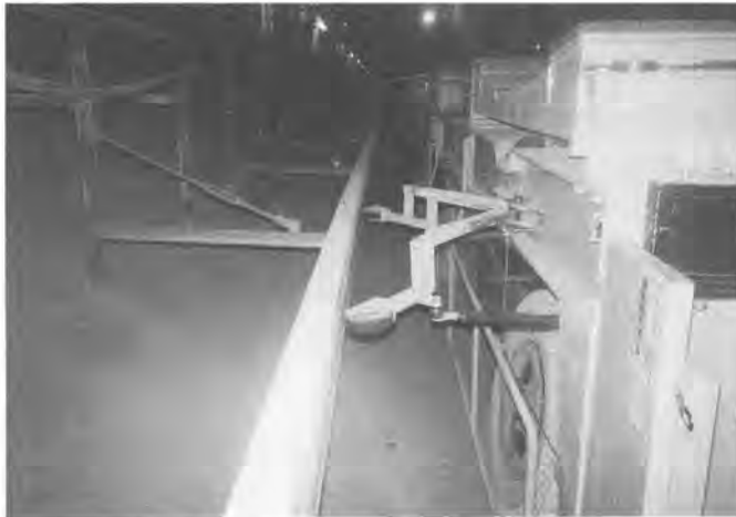
写真—3 ガイド板設置状況
