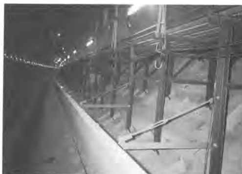
写真-5 坑内通路ブラケット
