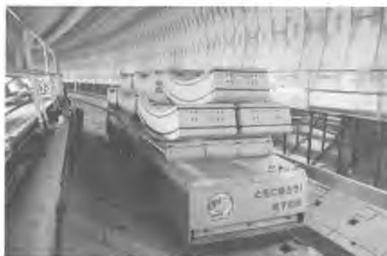
写真-1 坑内走行状況
