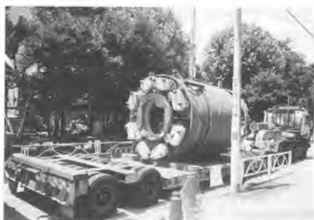
写真1 小断面シールド引き上げ
