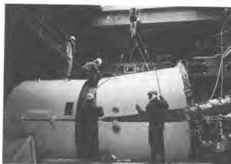
写真2 増径改造状況
