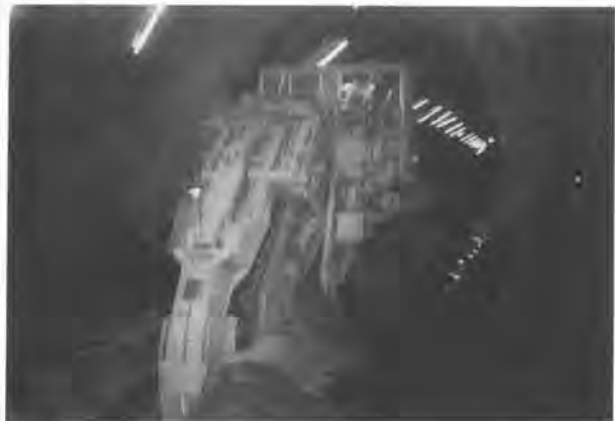
写真-4 トレンチャー坑内掘削状況
