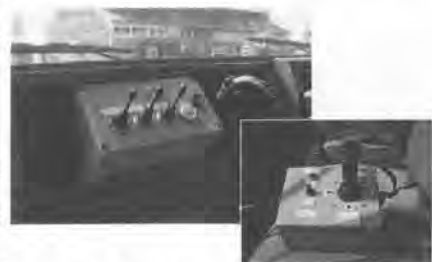
写真-3 散布制御盤(上)、ノズル操作盤(下)
