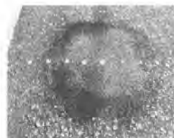
写真-8 施工2ヶ月後（路上）
