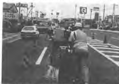
写真-1 従来工法（人力施工）
