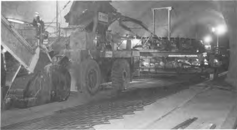
写真－3 施工状況（北陸自動車道能生トンネル内）
