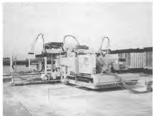
写真-2 自動ハツリロボット
