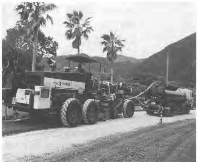
写真-2 施工状況
