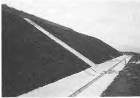
写真-5 施工直後の法面状況
