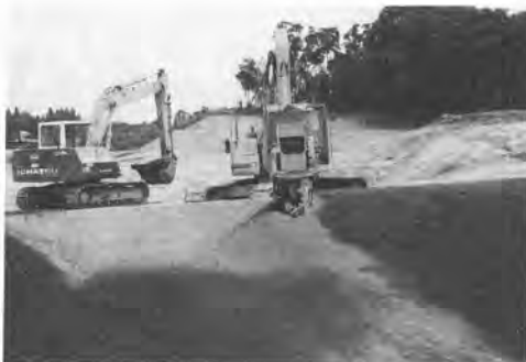
写真-7 盛土法面への施工状況
