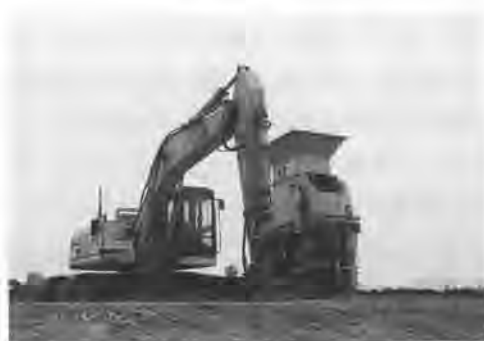
写真-1 高速ベルトコンベア式撒きだし装置
