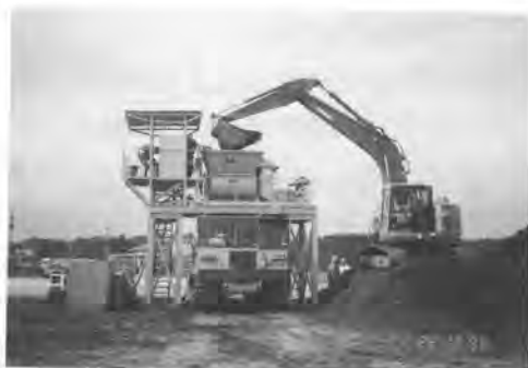
写真-3 生育基盤材料の製造状況
