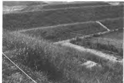
写真-8 施工後6ヶ月の法面状況
