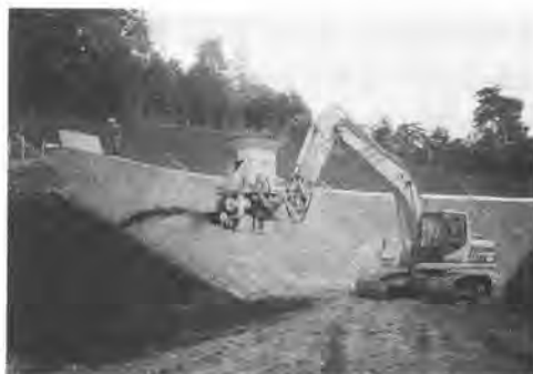
写真-4 生育基盤の造成状況
