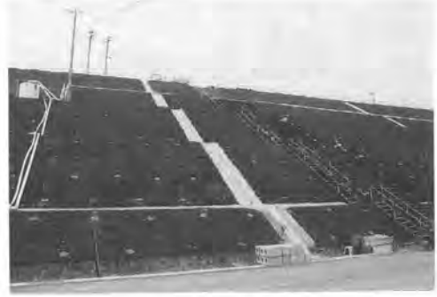
写真-6 施工後1年の法面状況
