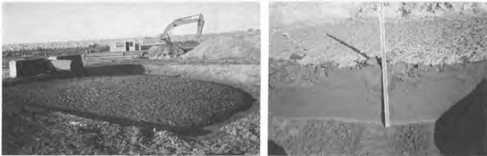
写真-2 固化処理土（75kg/m 3 添加）打設状況及び掘削断面
