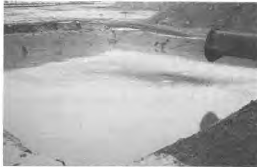
写真-1 無添加土（含水比 100%）の打設状況
