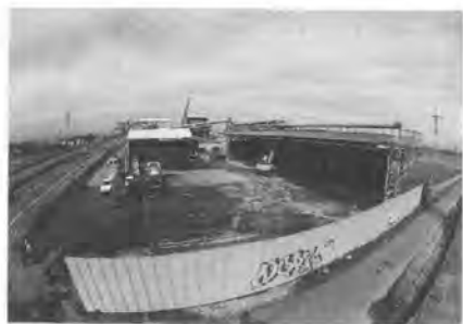
写真—2 土砂ストックヤード
