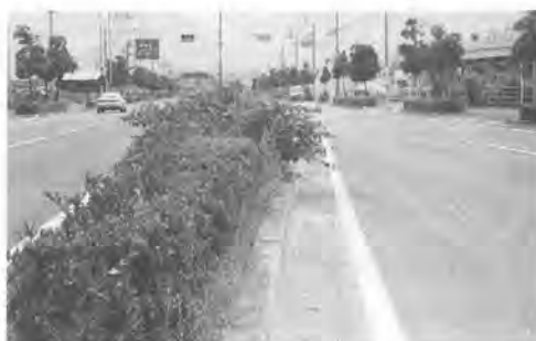
マルチング未施工の植樹帯
